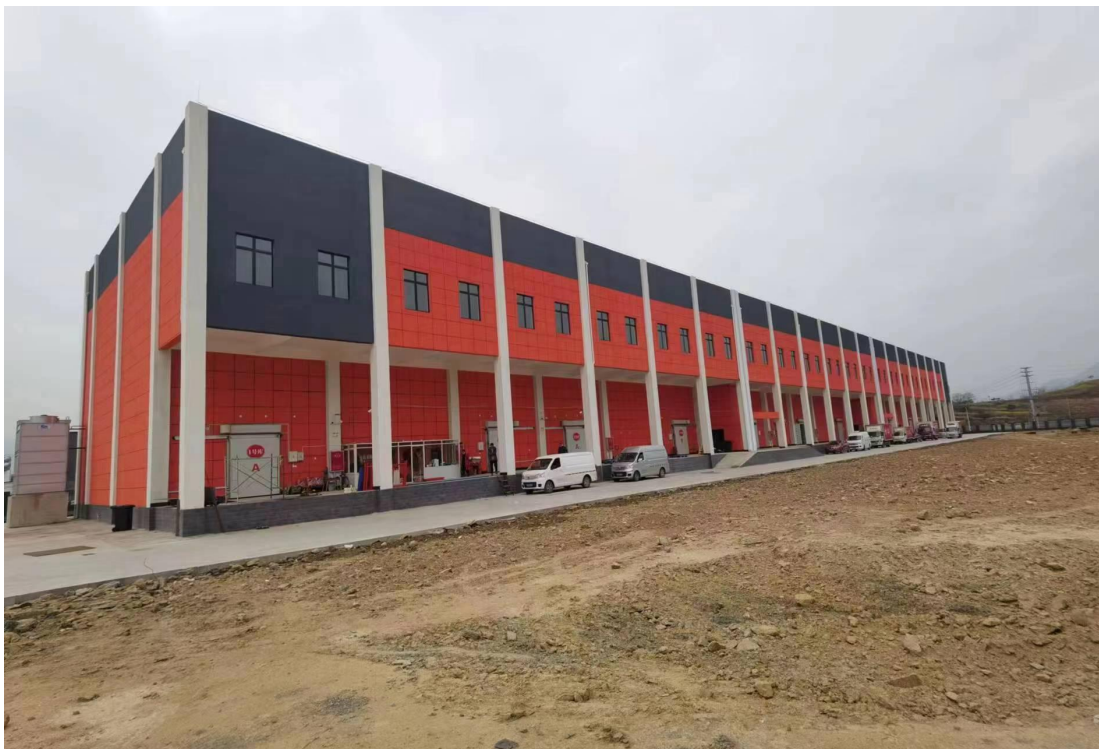
五、广元新食代食品有限公司一期厂房冷库实景图
